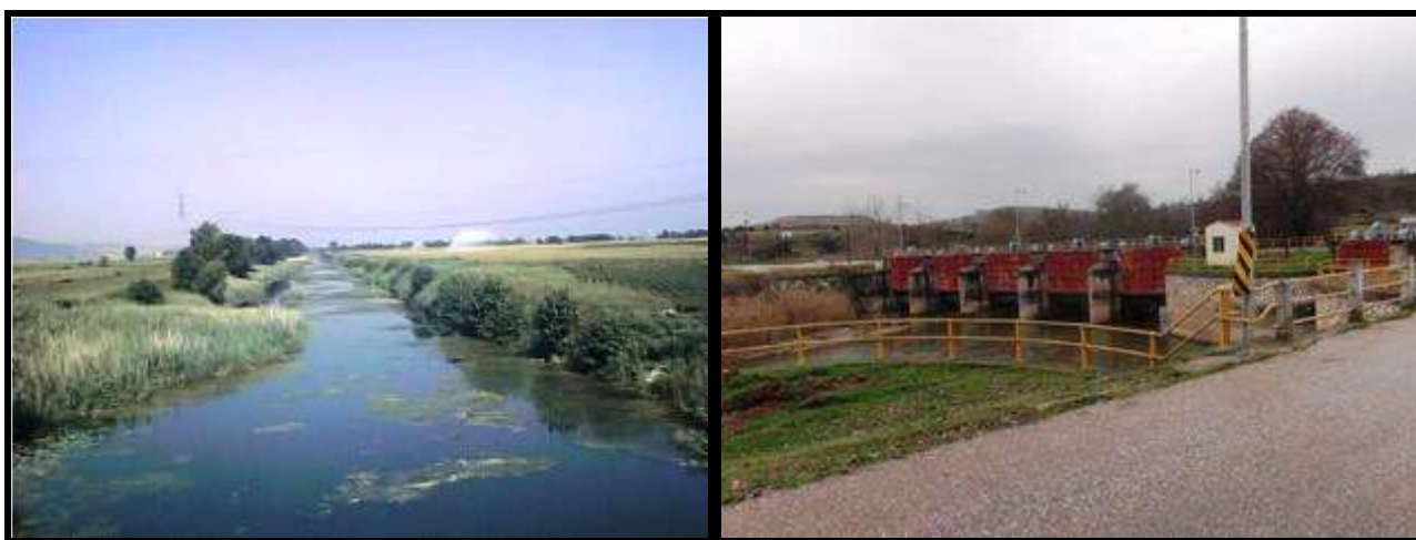
Εικόνα 3. Κεντρική Τάφρος Φιλίππων (αριστερά) και Φράγμα «Ρουφράκτης» Συμβολής (δεξιά) (Φωτο: ΔΑΟΚ Καβάλας αριστερά και αρχείο κας Σαρίγκολη, 24-02-2016).
