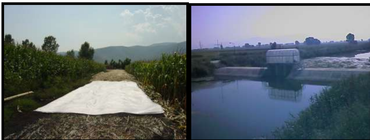
Εικόνα 12. Κατασκευή δρόμων και θυροφράγματα στα Τενάγη (Φωτο: Αρχείο ΔΑΟΚ Καβάλας).
