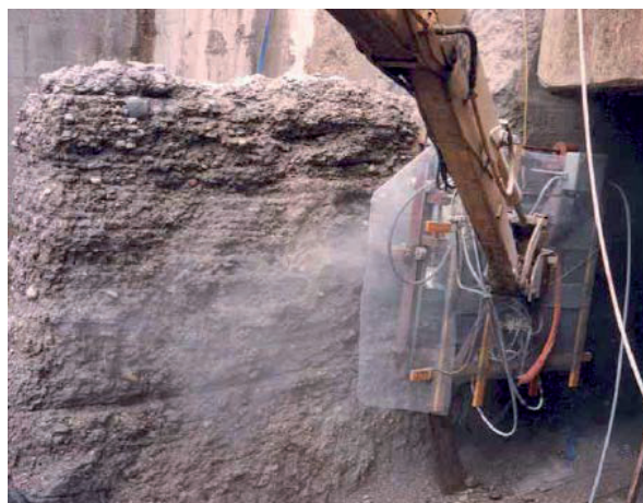
Εικόνα 6 - Αποδιοργάνωση σκυροδέματος με υδροκοπή (hydrodemolition) σε κάθετη επιφάνεια (Χρήση εξοπλισμού με ρομποβραχίονα)
