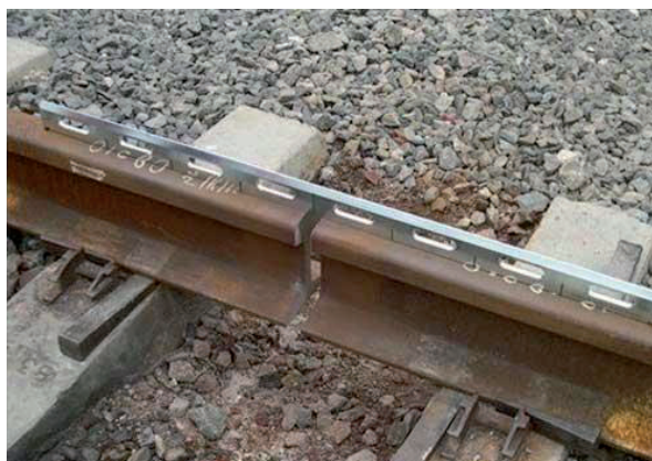
Σχήμα 2 - Οδηγός για τη διάνοιξη των οπών κοχλίωσης του Κ.Μ.Α.
