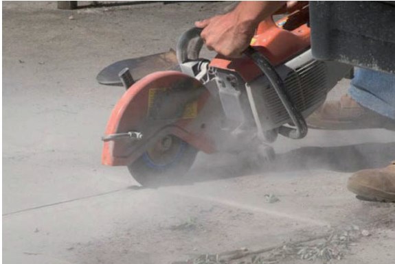
Εικόνα 1 - Αρμολόφτης χειρός για μικρής κλίμακας εργασίες κοπής αρμών
