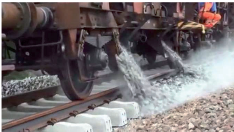
Εικόνα 2: Σκυρόστρωση
