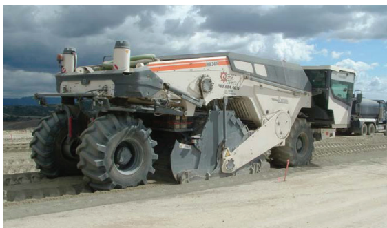
Εικόνα 1 - Μηχάνημα ανάμιξης (reclaimer, stabilizer)
