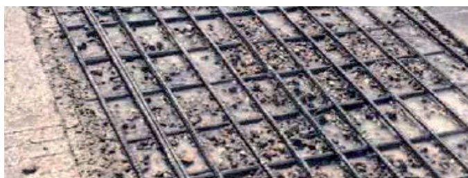
Εικόνα 7 - Αποδιοργάνωση σκυροδέματος και αποκάλυψη οπλισμού με υδροκοπή (hydrodemolition)
