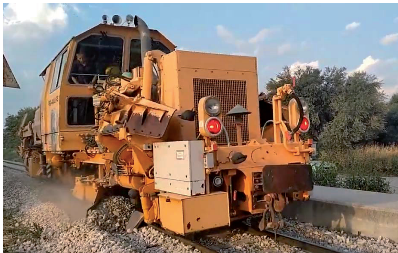
Εικόνα 2 - Ρεγκαλέζα (ballast regulator)
