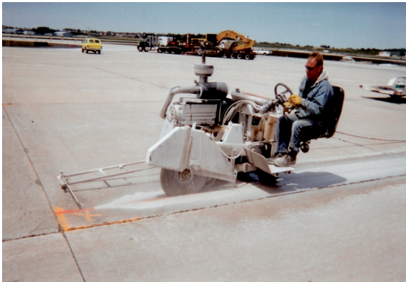
Εικόνα 3 - Αρμολόφτης εποχούμενος για μεγάλης κλίμακας εργασίες
