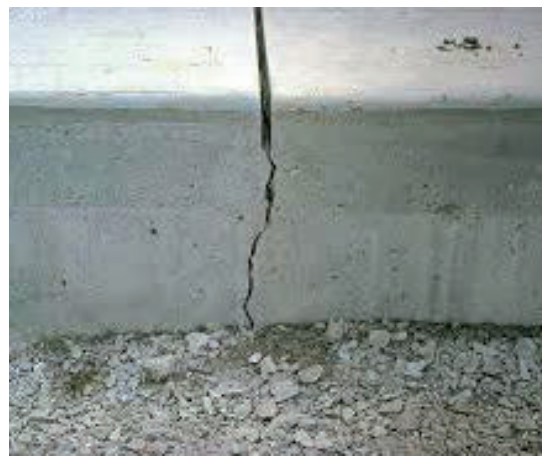
Εικόνα 6 - Η λειτουργία του ψευδαρμού
