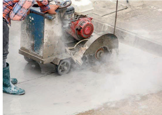
Εικόνα 2 - Αρμολόφτης πεζού χειριστή για συνήθεις εργασίες
