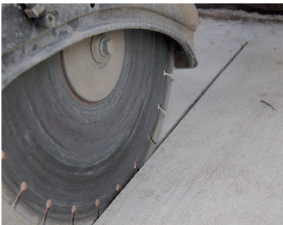
Εικόνα 5 - Κοπτικός δίσκος αρμολόφτη
