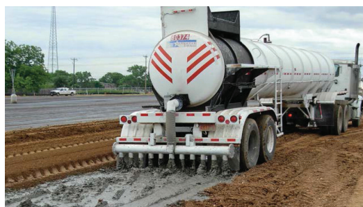
Εικόνα 4 - Όχημα διανομής τσιμεντοπολτού
