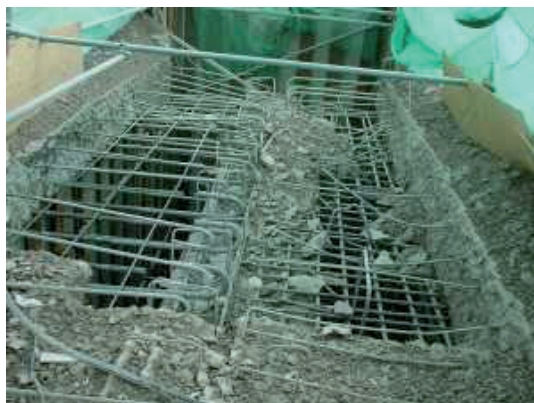
Εικόνα 5 - Αποσύνθεση πλάκας οπλισμένου σκυροδέματος με υδροκοπή (hydrodemolition) με ταυτόχρονη αποκάλυψη του οπλισμού
