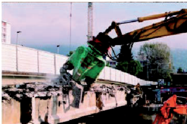
Εικόνα 3 - Καθαίρεση φορέα οπλισμένου σκυροδέματος με υδραυλική σιαγόνα βαρέως τύπου
