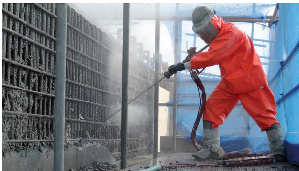
Εικόνα Α1: Προστατευτική εξάρτηση χειριστή λόγχης υδροκοπής
