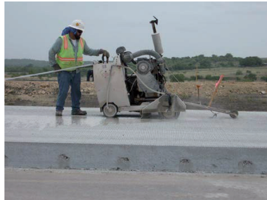
Εικόνα 4 - Αρμολόφτης "υγρού τύπου"
